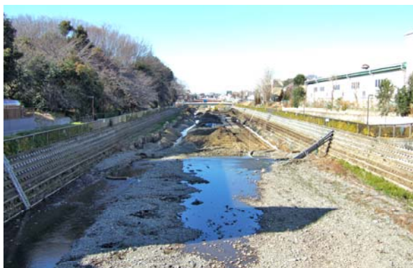
2014.1.16 工事区間から排水が始まる
