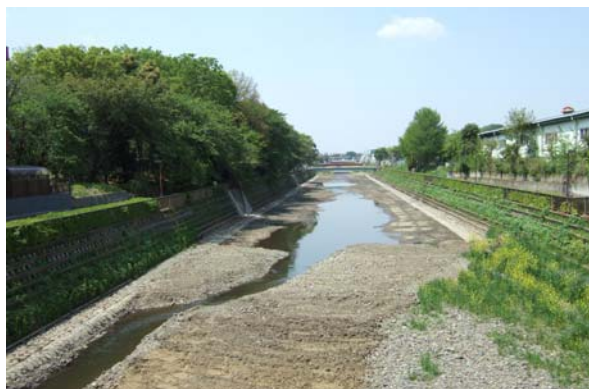
2014.4.24 工事境が堰となり工事終了
