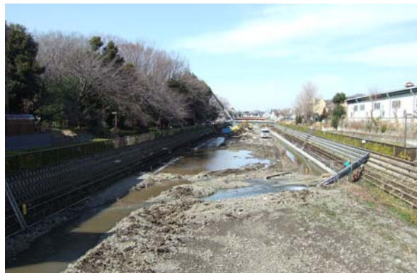
2014.2.28 みお筋が右岸側に固定する
