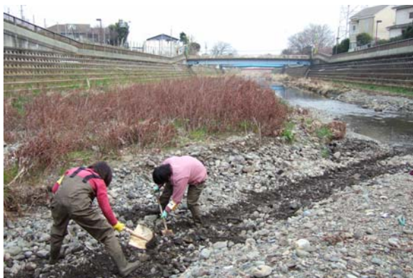
2015.2.22 水路消失で掘り直す
