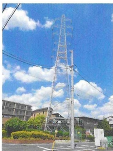
川世線31 昭和40年 10月建設、高さ50m
