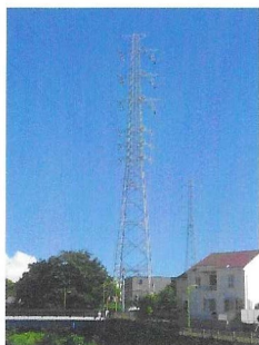
川世線34 昭和56年 6月建設、高さ59m
