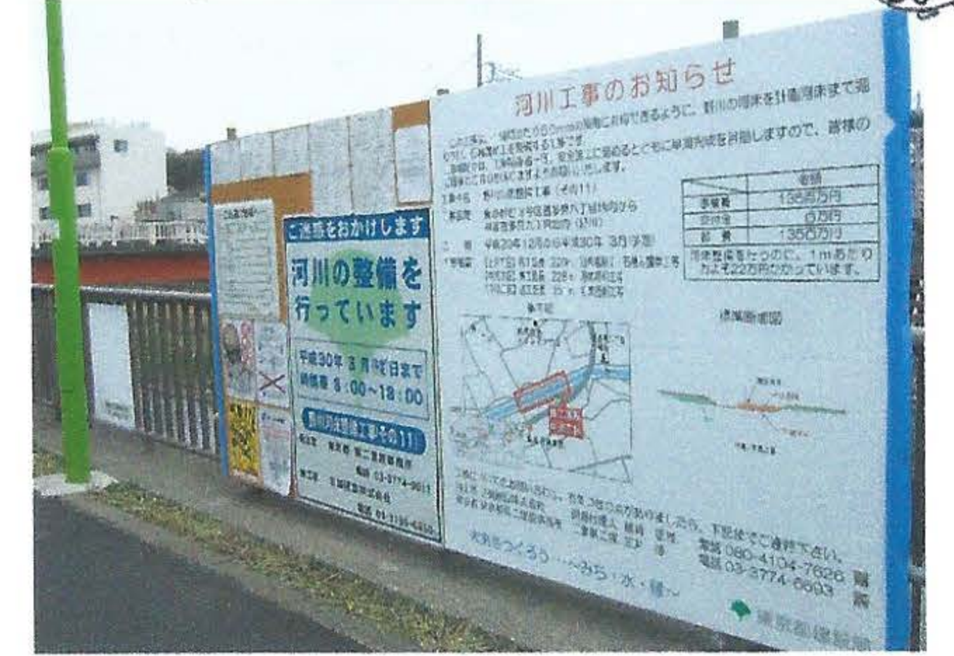
雨などの影響で工事が遅れています
